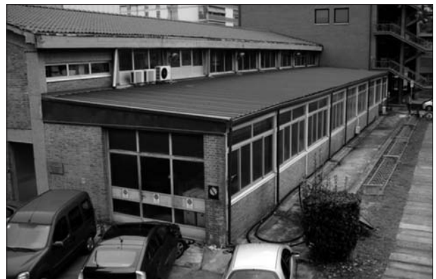
Figura 1. Immagine fotografica dell'officina meccanica oggetto di studio
