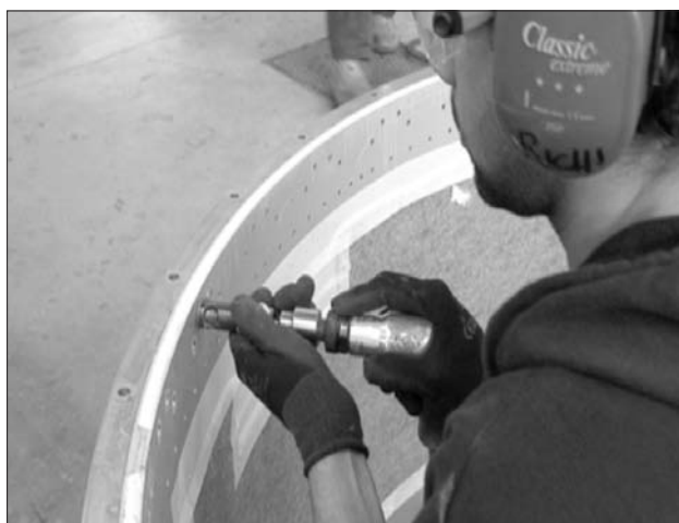
Figura 3. Esempio di fase preparatoria del foro: svasatura
