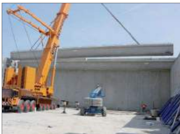
Figura 3. Fase di montaggio del tetto schermato del CNAO
