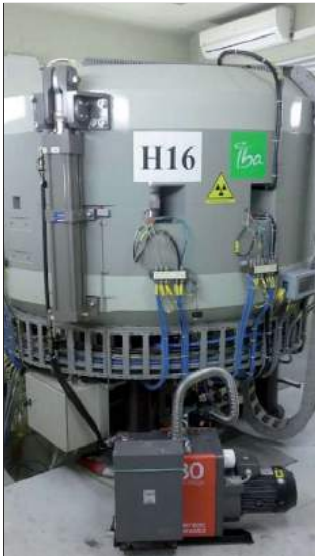
Figura 1. Il ciclotrone IBA "Cyclone® 18/9" installato presso il LENA
