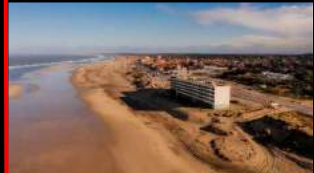
Erosion de falaise à Soulac 2023 (200 mt → 20 mt)
